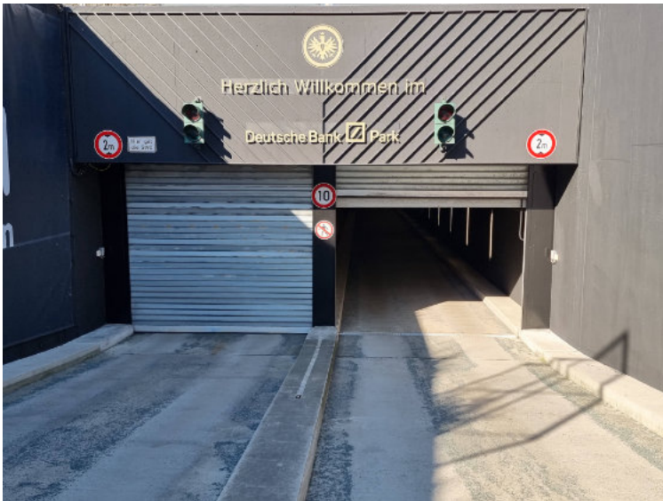
Durch das Rolltor gerade aus in die unterste Ebene (P0) in Richtung Adler Business Club
